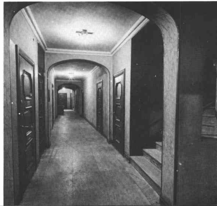
Vätan 20, entré och korridor t bakre trapphus
