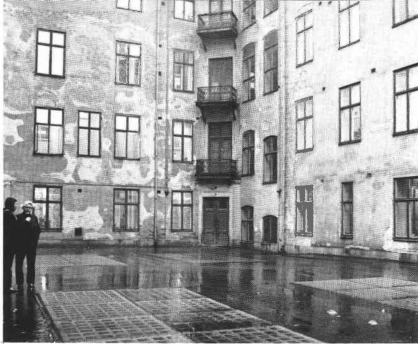
Stadsäga 1 (inom kv Pensionären), gård
