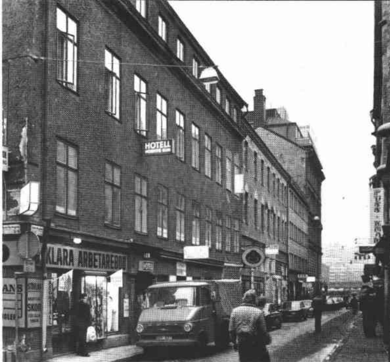
Kvartersfasad mot Gamla Brogatan
