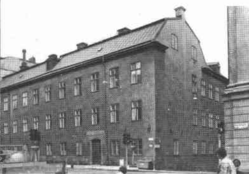
Ladugårdsbron 1 (del av) Blasieholmstorg 8
