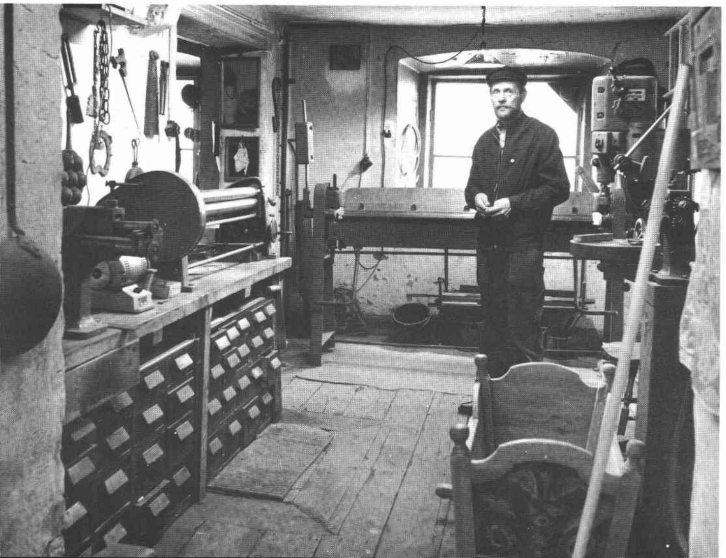
Italien Större 9, plåtslageri
