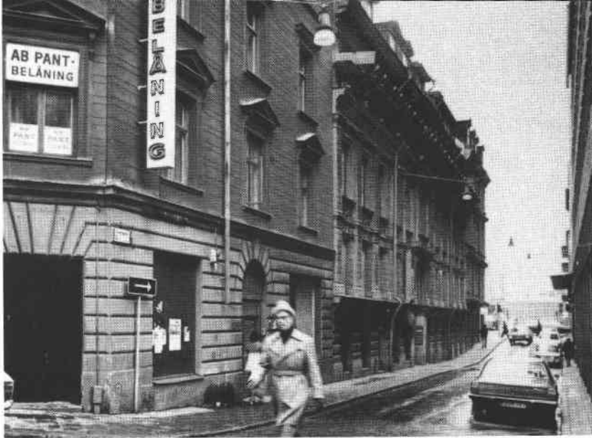
Kvartersfasad mot Tunnelgatan
