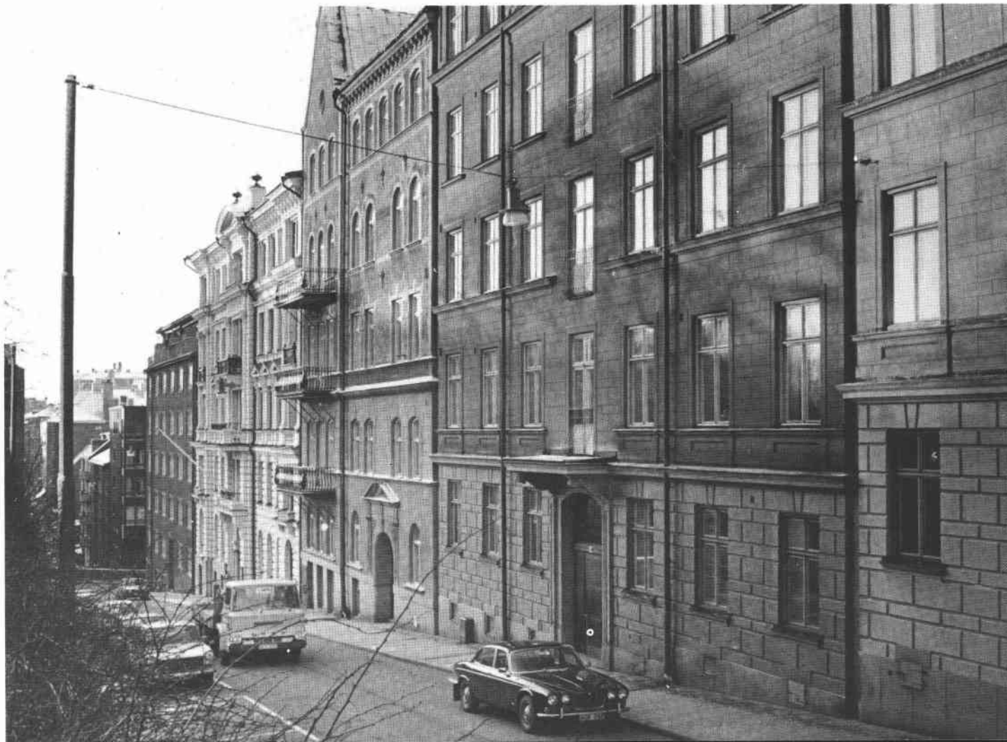
Kvartersfasad mot Kammakargatan
