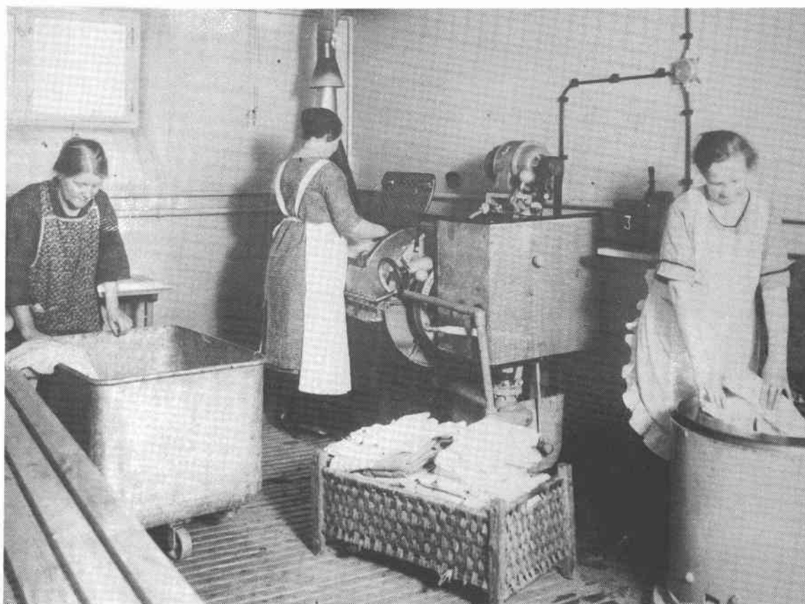
Fig 31 Tvättstuga med maskinell utrustning i en av HSB:s fastigheter.
