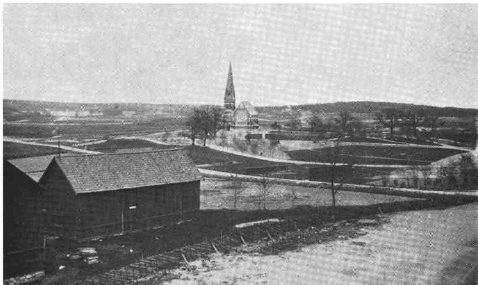
Bild 16. Gustaf Adolfskyrkan med omgivningar från Karlavägen 84 omkr. 1895. T.v. i fonden Värtan och »artilleriskottvallen». T.h. om kyrkan Borgen, som ännu har kvar sin baldakin. Obs gärdesgårdarna utmed Karlavägen och Banérgatan.
