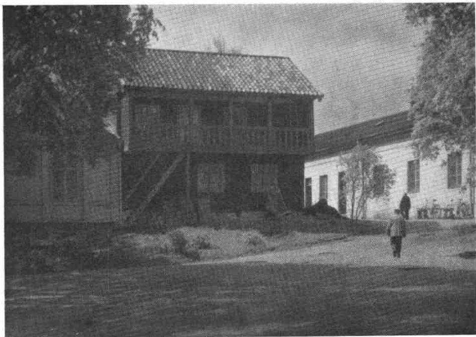
Fig. 10. Loftboden vid Sabbatsberg efter restaureringen 1949. Fasaden mot nordost. Foto G. Selling 1950.
