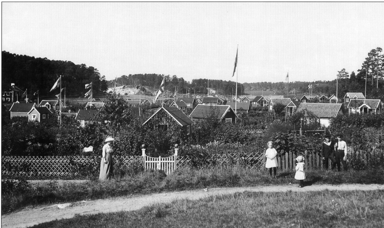
Söderorts första koloniträdgårdar anlades i Dalen 1911. Större delen av området försvann i samband med det planerade sjukhusbygget. Foto Axel Swinhufvud, Stockholms stadsmuseum.
