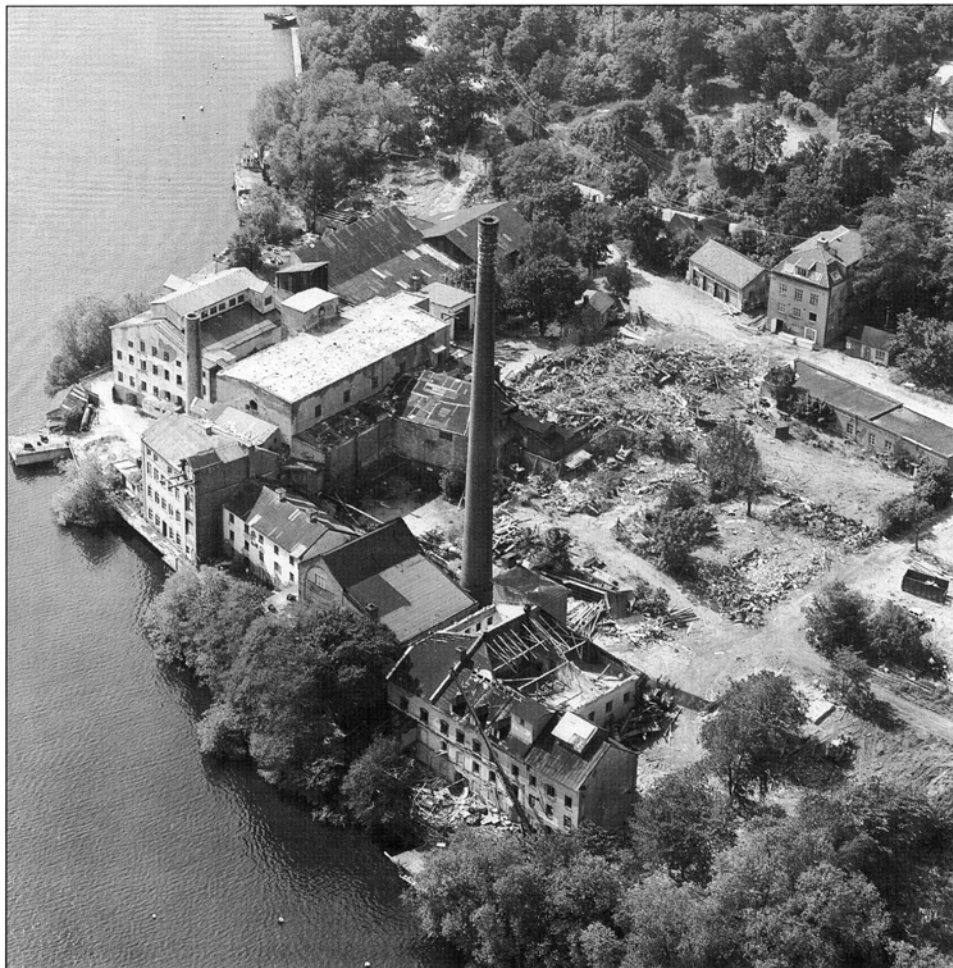
Svartviks benmjölsfabrik i 1980 i långt gånget förfall några år före rivningen. Foto Ingvar Lundkvist, Stockholms stadsmuseum.
