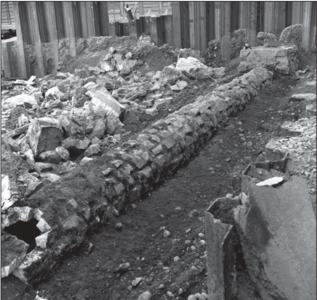
Figur 42. Den ojämförligt största anläggningen som påträffades var avloppskulverten A 52 från slutet av 1800-talet. Den var närmare 54 meter lång och 1,15 meter i diameter. Brunnen syns längst upp i nordöstra hörnet. Bild från söder.
