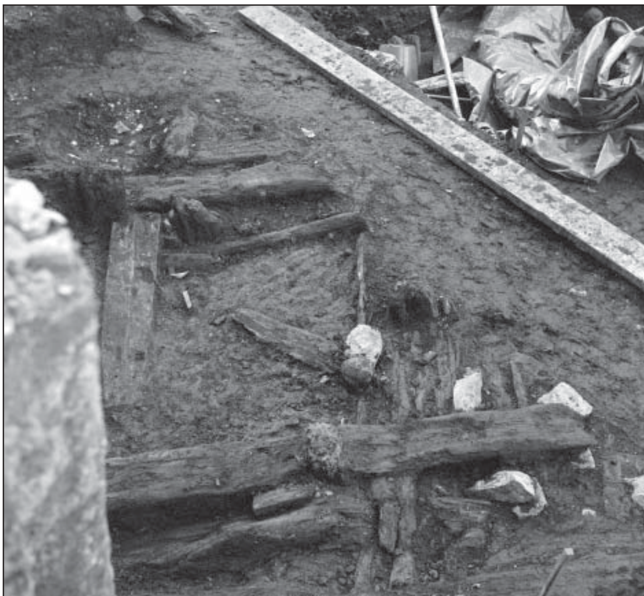
Figur 33. Huset A 14 under utgrävning. Bild från öster.
