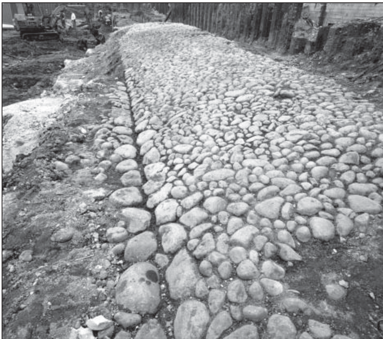
Figur 49. Vattugatan från 1640-talet. Den kraftiga välvningen ner mot rännstenen har sannolikt orsakats av sättningar intill den huskropp som revs. Bild från sydväst.
