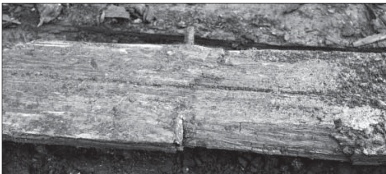
Figur 32. Detaljbild på golvplanka i A10. Konstruktionen med sammanhållande dymlingar syns tydligt.
