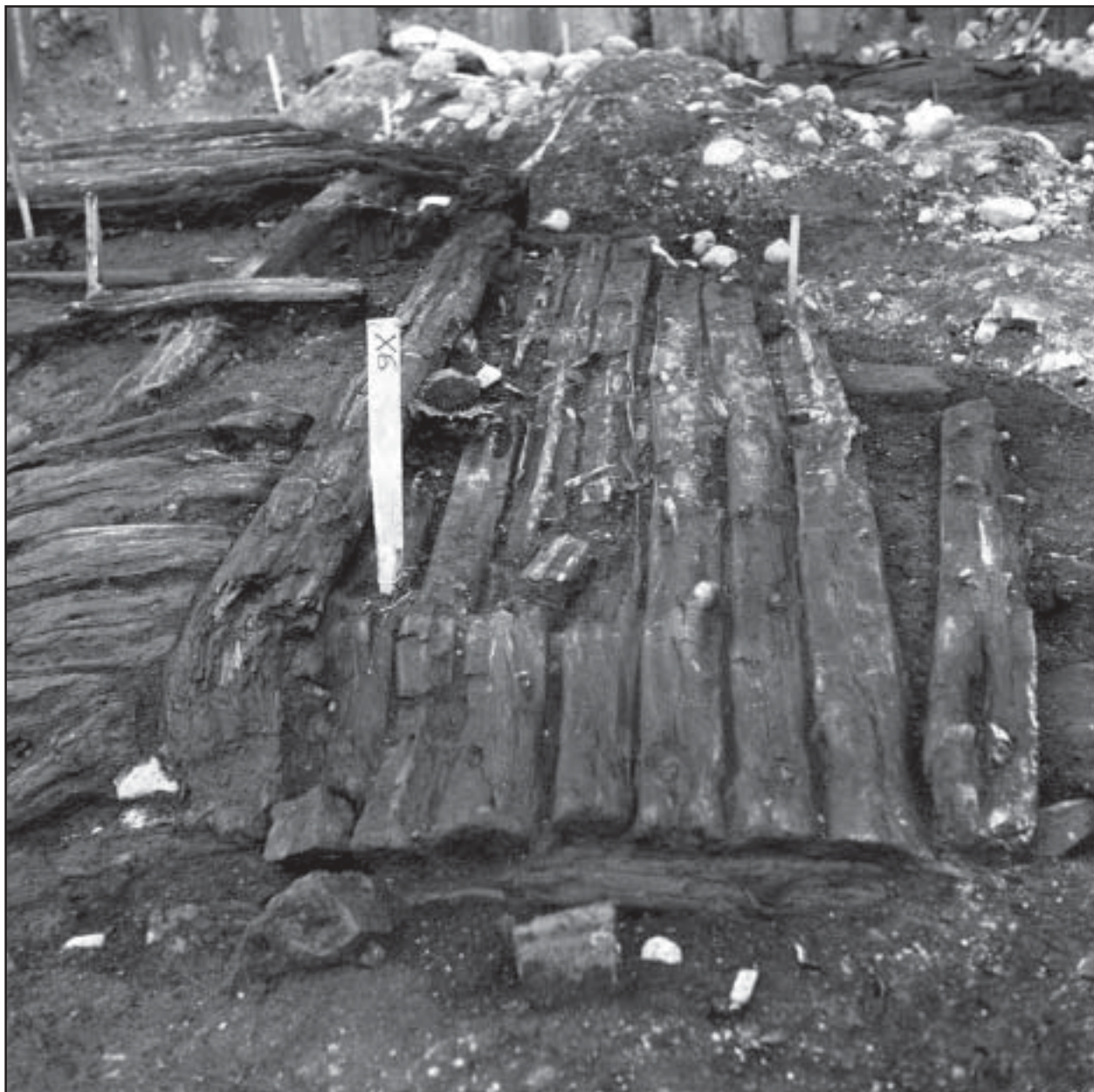
Figur 27. Under början av 1600-talet byggs fähuset A1 om för tredje och sista gången. Här syns nordvästra delen med en del av det inrasade väggtimret (konstruktionsfas 3). Bild från norr.
