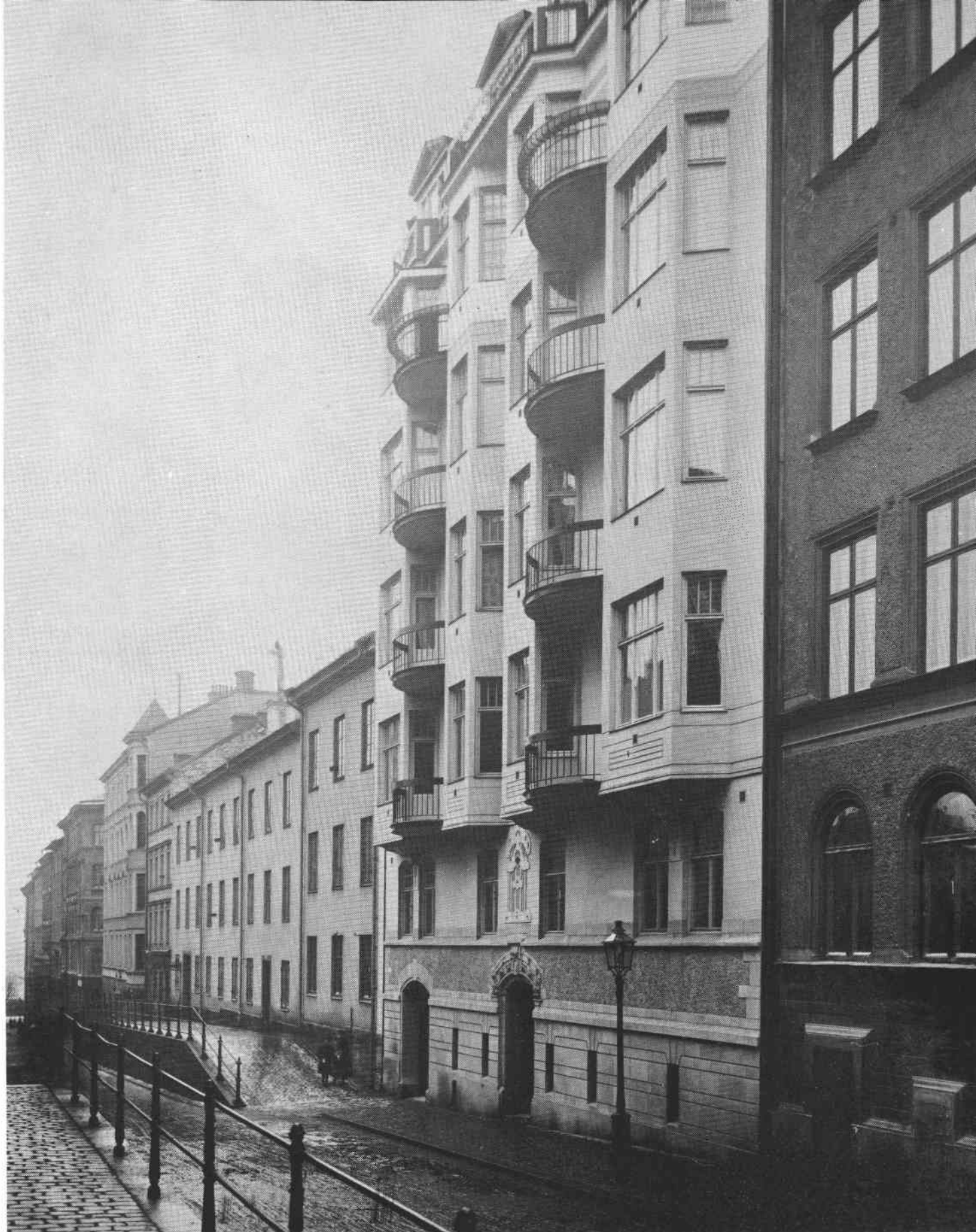
Bild 5 Styrmanngatan söderut med Lindormen nr 19, 20 i förgrunden. Gatan har stora nivåskillnader och är stenlagd dels med storgatsten, dels med kullersten och är mycket lerig. Gatubelysning finns. Bilden är tagen omkring 1910 och finns i SSM arkiv.
