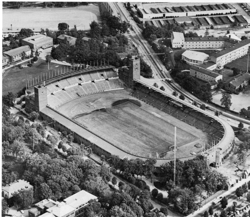
Stadion med den nya fondläktaren som uppfördes 1958. Foto: Kjell Johansson.
