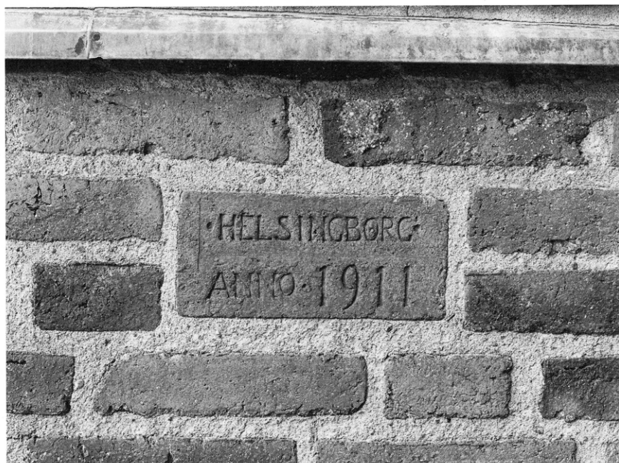
"Fasaderna äro murade med Helsingborgs handslagna svenska tegel, stora formatet, med 2 cm fogar." Foto: Carl Heideken 1979.
