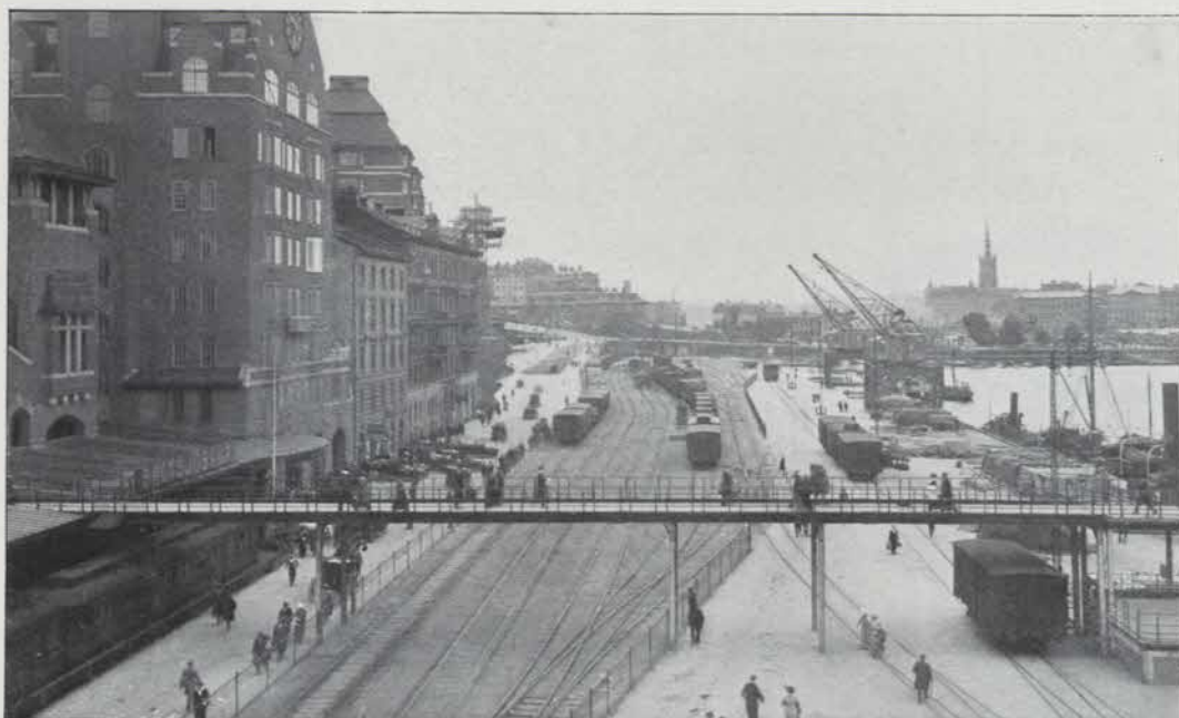
VY ÖVER DEN FULLBORDADE HAMNANLÄGGNINGEN SEDD FRÅN MAGASINSBYGGNADEN.
