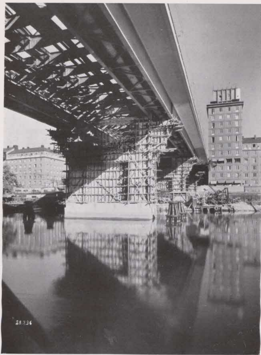
Fig. 26. Brons östra sidoparti med utkragad gångbana av armerad betong.
