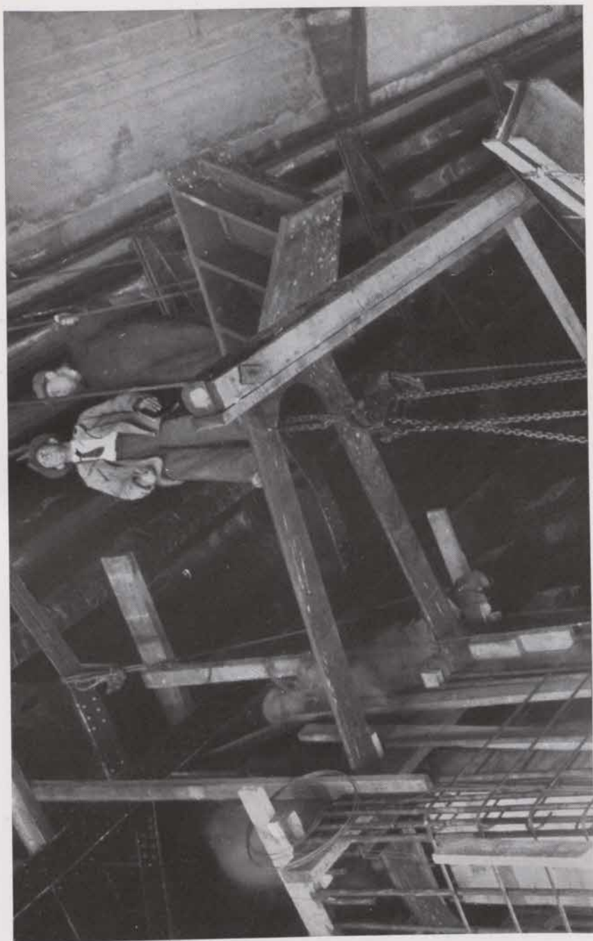
Fig. 9. Plattjämsarmering med tryckplatta i ytterpelarnas konsoler.
