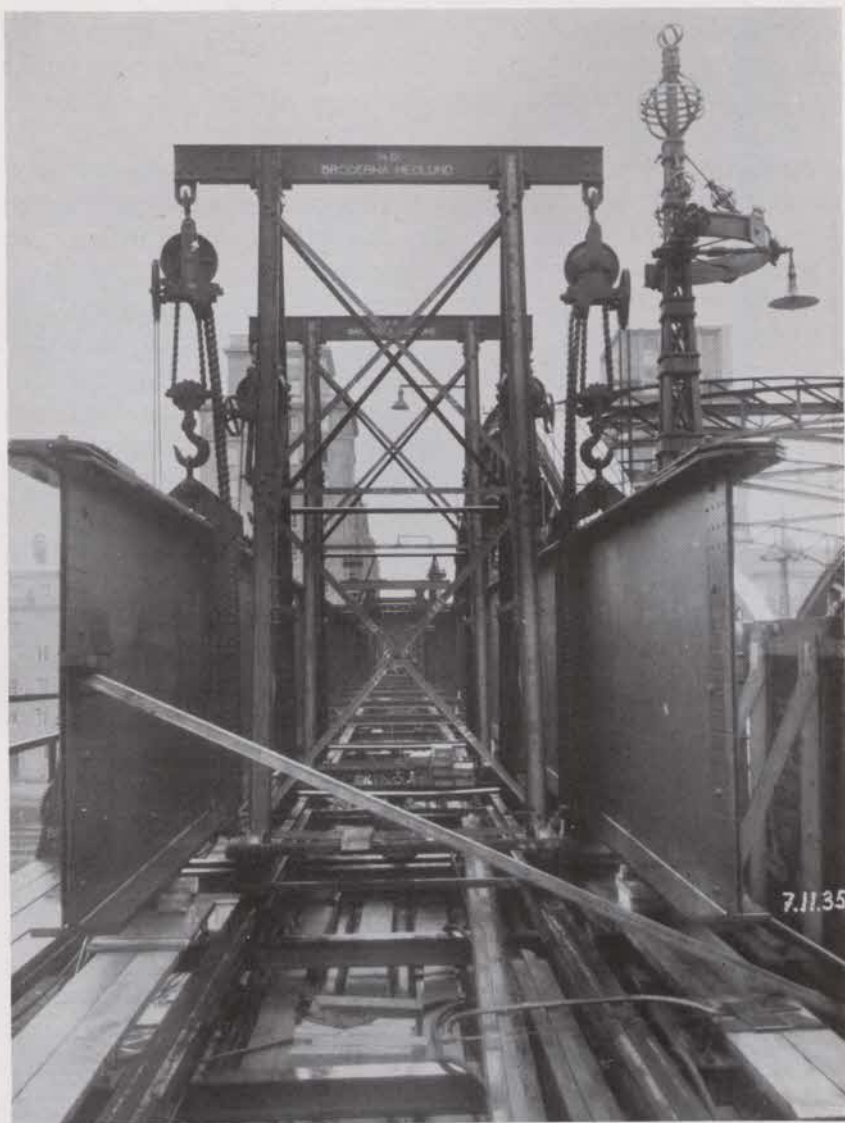
Fig. 12. Ett huvudregelpar transporteras till sin plats, hängande medelst lyftblock i bockkranarna. Första byggnadsskedet.
