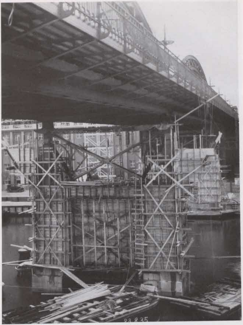
Fig. 10. Formsättning för en mellanpelare.
