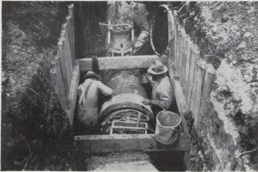
Gjutning av rörskarv.
