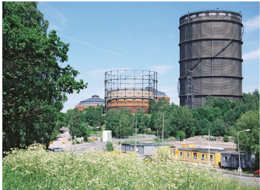
Gasverket. Arkitekt F. Boberg m.fl. Den högra klockan är en s.k. MAN-klocka (Maschinenfabrik Augsburg-Nürnberg) från 1932. I förgrunden de två gasklockor som fortfarande används men hela området står inför en omgestaltning. Förhoppningsvis kan huvuddelen av områdets byggnader leva vidare med andra användningar så att det även i framtiden går att avläsa områdets historia. Foto: Göran Fredriksson, SSM.
