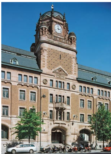
Centralposten, 1898-1904 arkitekt F. Boberg Postens huvudkontor flyttade härifrån till Solna hösten 2003. Men redan dessförinnan hade den stora posthallen i bottenvåningen varit stängd i flera år. Foto: Göran Fredriksson, SSM.
