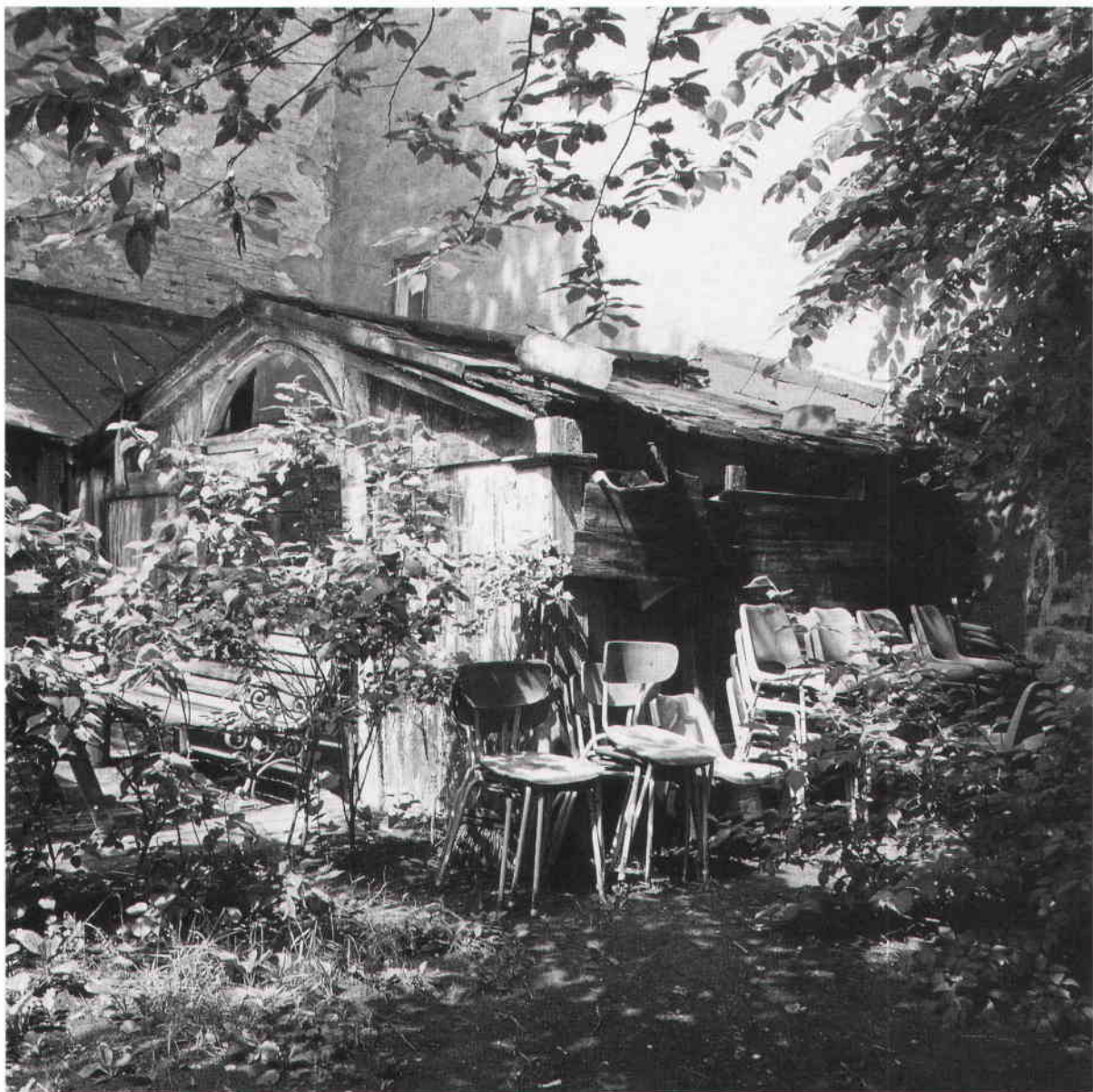
Lusthusets tillstånd 1988. Dörr- och fönsterpartierna är vandaliserade och hammarbandet som låst östra väggens överdel har försvunnit. Foto Claes Reichmann. SSM.
