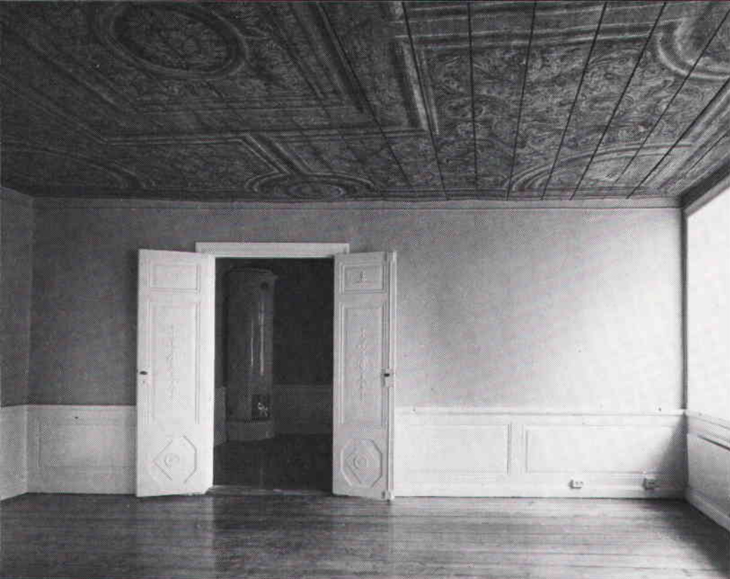
Den större salen i vän 2 tr. Ovanför det framtagna målade paneltaket finns det genomgående bjälktaket, som frilagts i den inre mindre salen.
