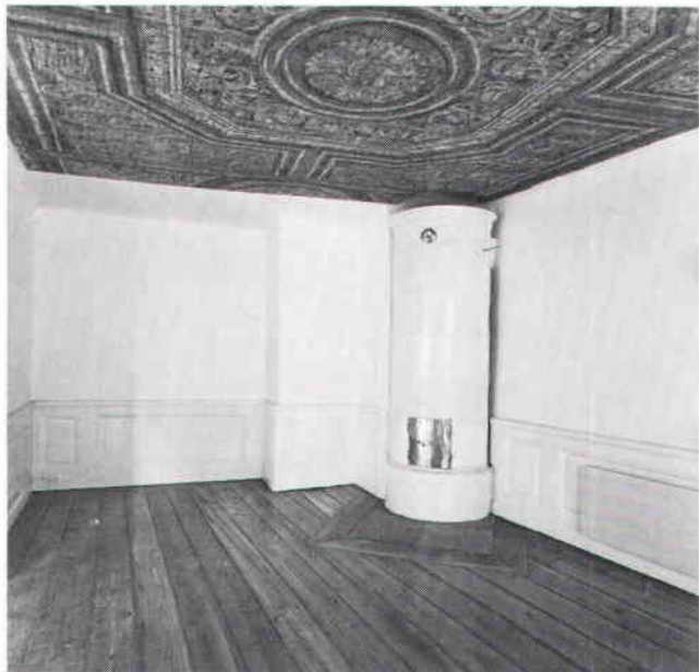
Lilla salen i vån 3 tr. Paneltaket härrör från motsvarande rum i våningen under, där det togs ner till förmån för bjälktaket.
