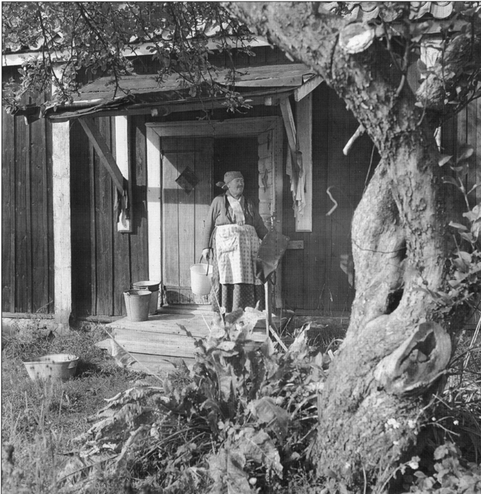
Stora Tensta med dess allra sista hyresgäst, 1966. Foto Göran Fredriksson, Stockholms stadsmuseum.
