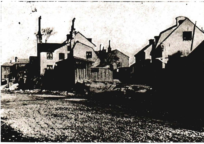
Tulegatan vid Pärstickaregränden omkring år 1900 med Realläroverkets byggnad i fonden.
