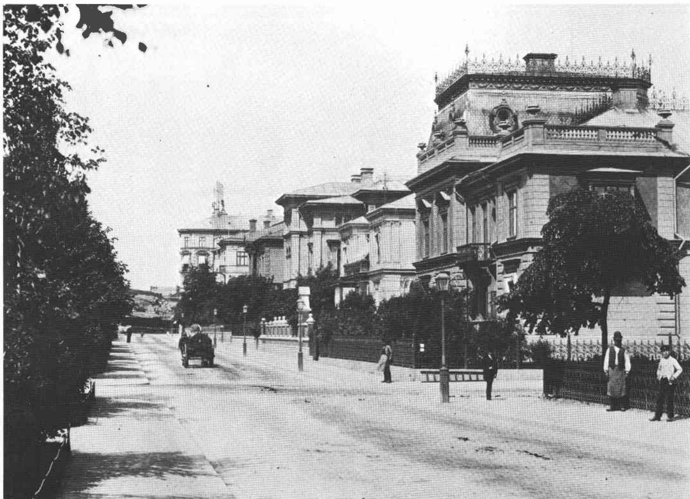
Karlavägen mot väster vid Floragatan på 1890-talet. Villan till höger, Linden 8, ses här i sin andra skepnad, tillkommen genom en grundlig ombyggnad 1885. Ursprungligen uppförd 1876, byggdes den om ytterligare en gång 1919-20 till det utseende den har idag. Där bakom syns de Heidenstamska och Adelsköldska villorna, den förra byggd 1876 och riven 1914.
