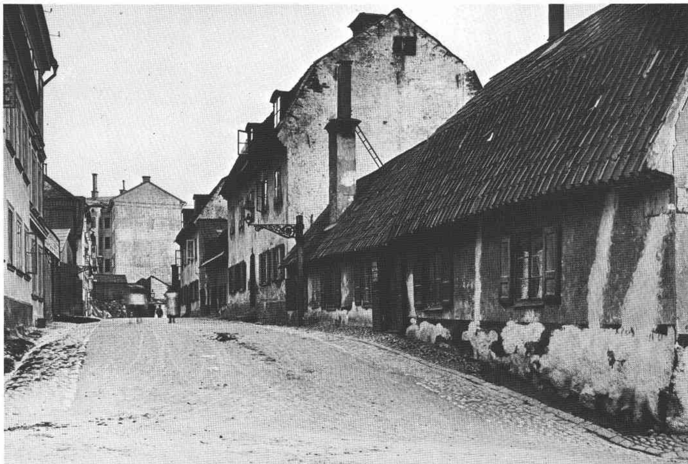
Stora Quarngränd eller Norrteljegatan mot söder 1901. Gatan fanns kvar tills Eriksbergsgatan började bebyggas med hyreshus strax före första världskriget. Husen till höger i kv. Lerlafven har alla fönsterluckor i gatuplanet, i huset vid fotogenlyktan är en Bröd, Matvaru och Diversehandel inrymd. I fonden brandgaveln till Rimbogatan 6, kv. Norrtälje 14, byggt 1882.
