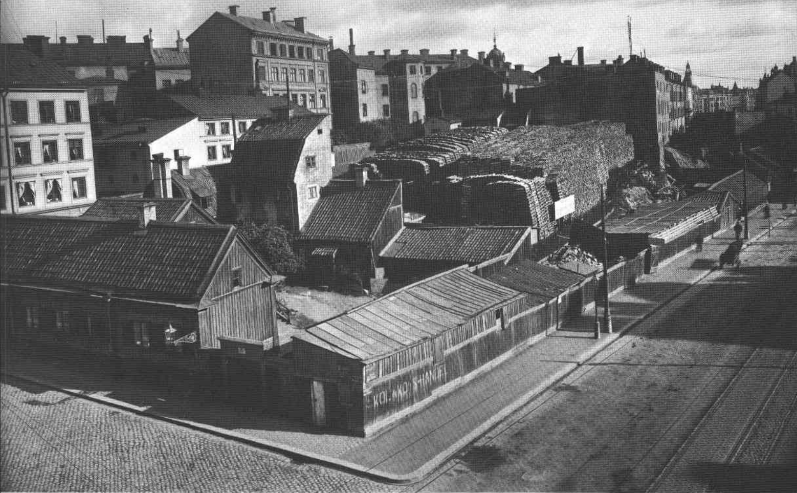
Kv. Häckelfjäll Större mot söder år 1905. Gathörnet motsvaras idag av Eriksbergsgatan och Birger Jarlsgatan. Till vänster i det envåniga trähuset låg krogen Vackra Klara, där bakom ses 1860-talshus vid Lilla Qvarngränd eller Rimbogatan, den högt belägna brandgaveln är densamma som på föregående bild. Husen bakom Ekström & Larssons anse- nliga vedlager byggdes på 1870-talet och revs för TRYGGs nybyggnad strax efter bilden togs. I fonden till höger skimtar Stureplan.
