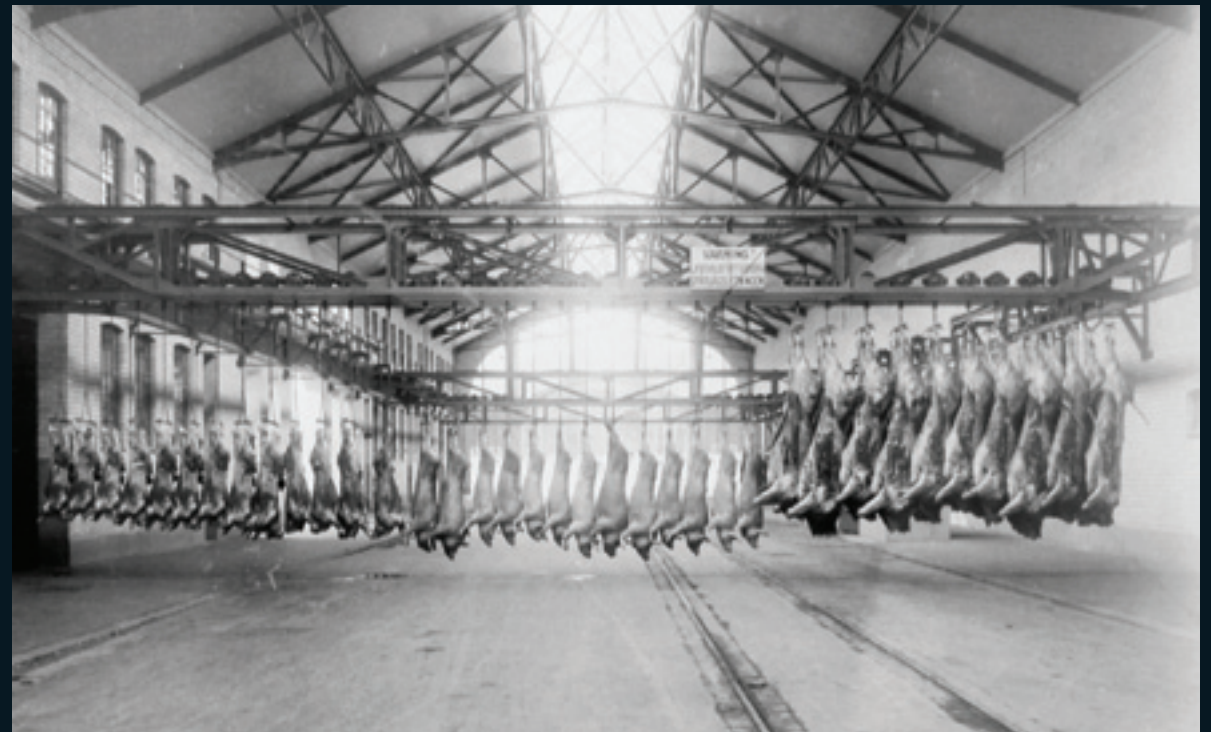
I stora förbindelsehallen kunde de hängande djurkropparna föras med traverser längs hallens längdriktning för att sedan föras in på rätt ställe i kylhuset.
