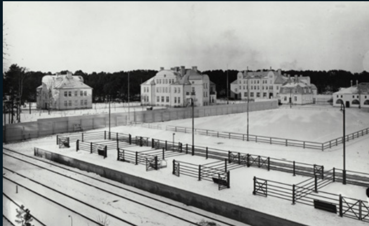
Perrong med väntfällor för djur som anländer med järnvägen. Byggnaderna är från vänster: bostadshus för veterinärer, kontorsbyggnaden, börshuset, portvaktshuset samt marknadshallen för svin- och småboskap.
